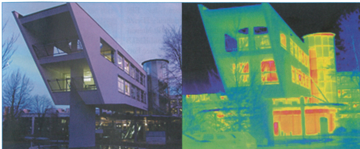
Detektion von Wärmebrücken durch Infrarot-Thermografie. Quelle: FH-Aschaffenburg ■
