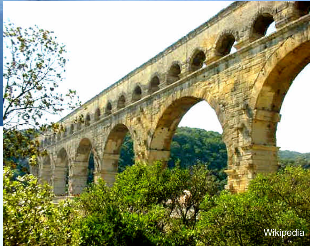
Pont du Gard (Frankreich)
