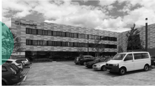
Fraunhofer-Zentrum für Hochtemperatur-Leichtbau HTL
